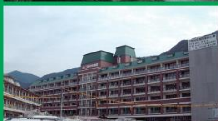
完成した三和中央病院（2001年12月1日）
