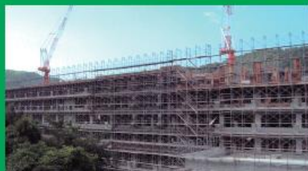
建設中の三和中央病院（2001年10月）
